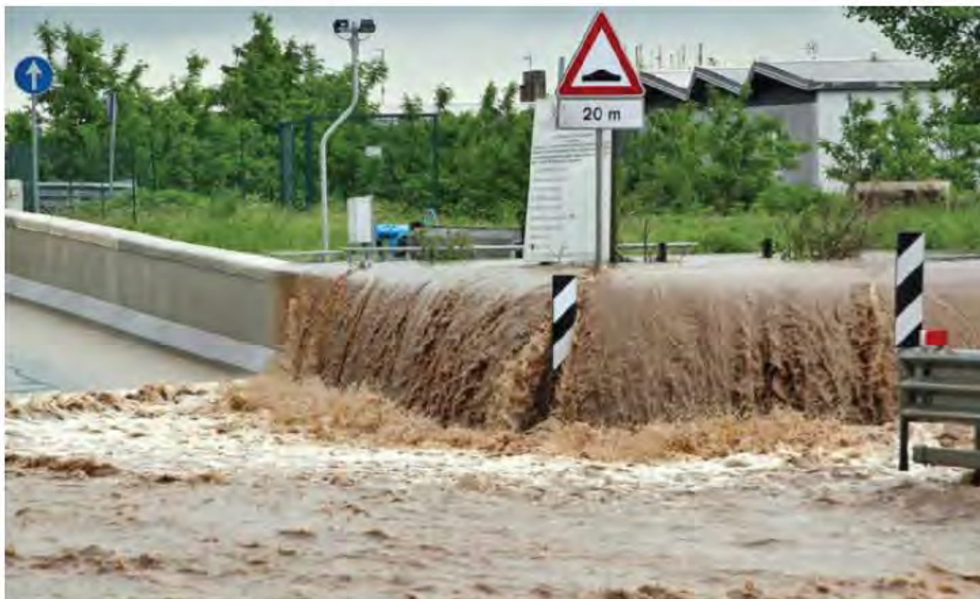
L'erosione del Tramigna: l'argine ha ceduto per una cinquantina di metri poco prima della confluenza con l'Alpone
