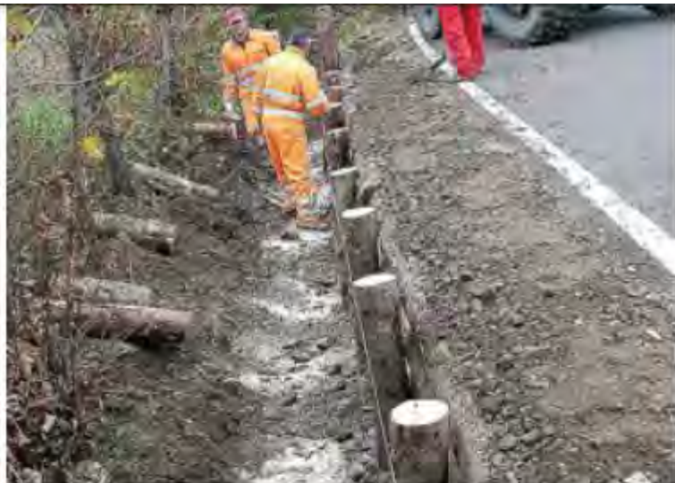
Lavori di ripristino dei corsi d'acqua dei Consorzi di bonifica. ARCHIVIO
