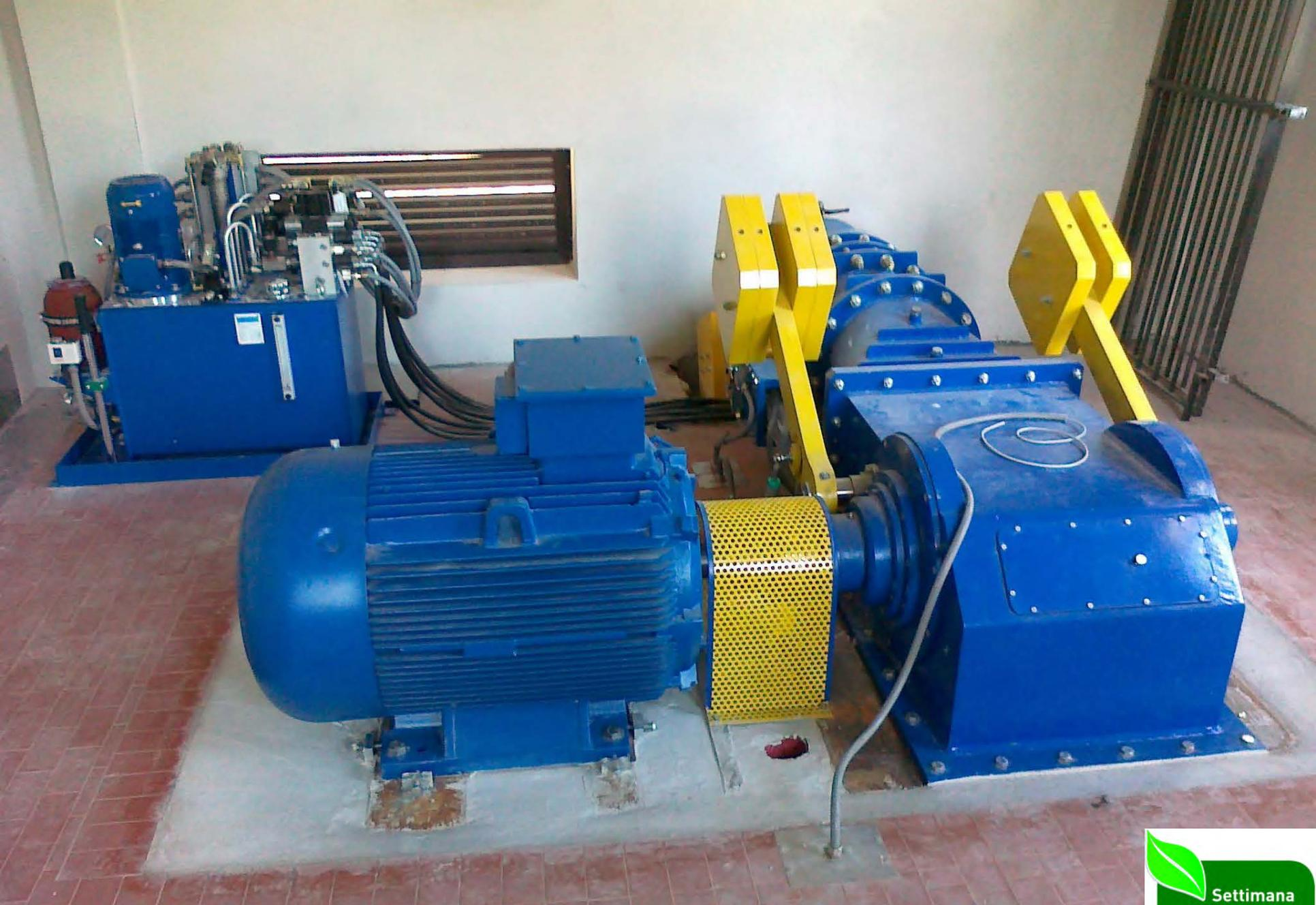
**CENTRALINA OLEODINAMICA, GENERATORE E TURBINA**
