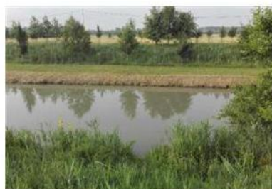
Un tratto arginale della Fossa Maestra dove è avvenuto lo sfalcio
