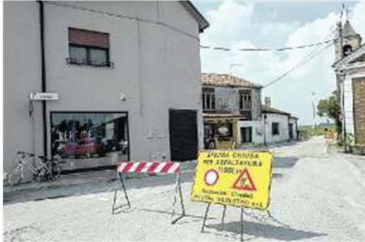
VIA CONDOTTI La strada è stata chiusa per asfaltatura ma i residenti non sono stati avvisati per tempo dei lavori
