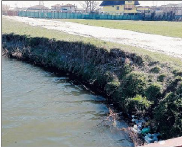
Lo smottamento lungo l'argine del Collettore Padano
