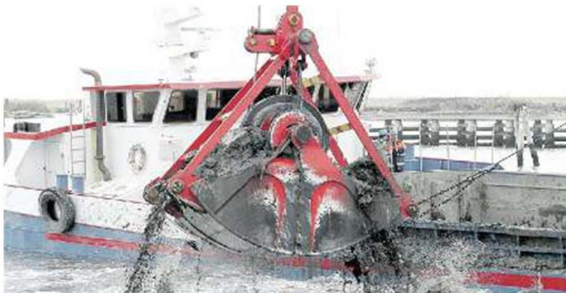
PORTO TOLLE Contro l'insabbiamento delle bocche di porto a Pila servono lavori urgenti e definitivi
