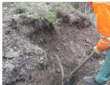
Il tunnel scavato dalle nutrie finiva nel fosso a lato della via
