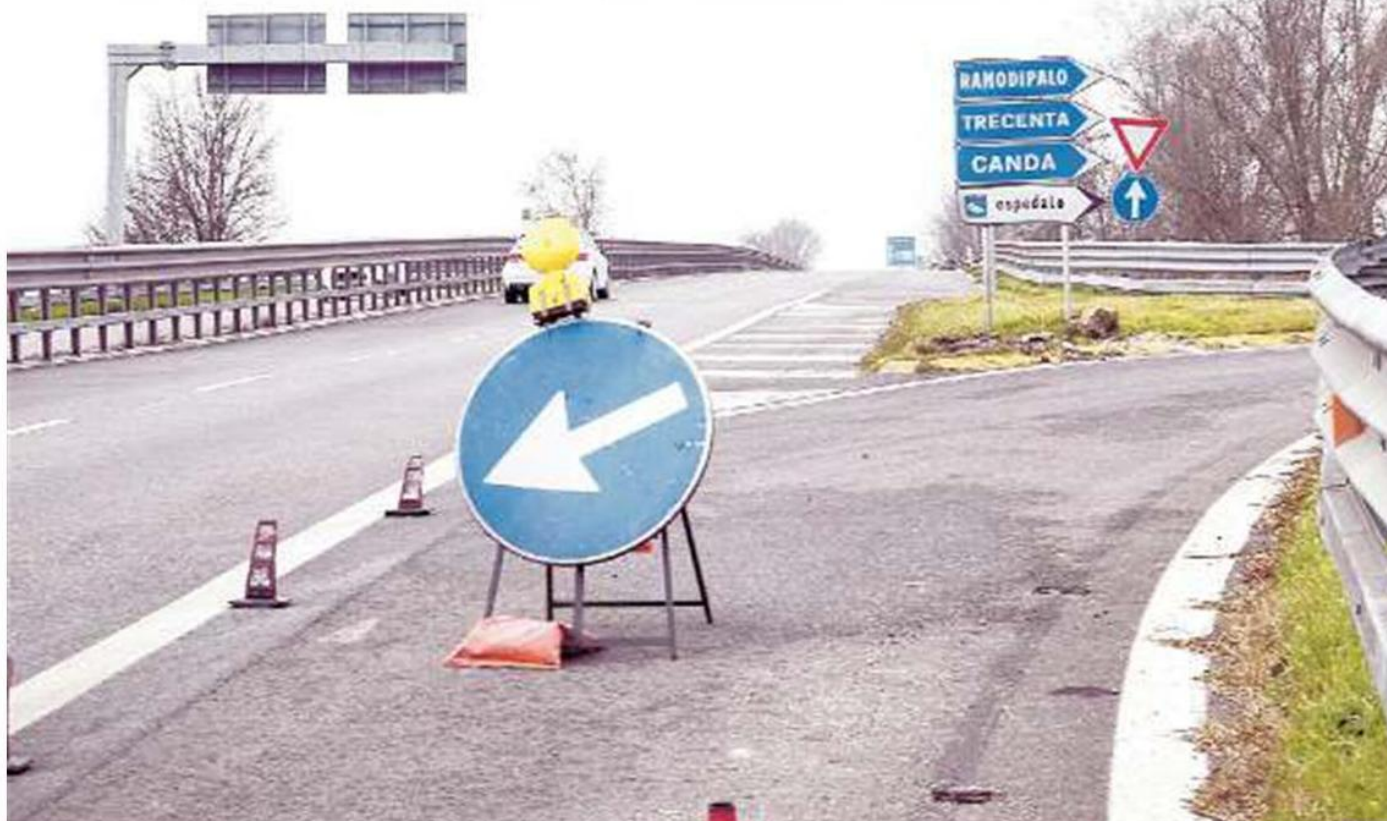
RIAPERTURA Dopo quattro mesi è prossimo alla riapertura lo svincolo che conduce verso l'ospedale, soggetto a lavori stradali
