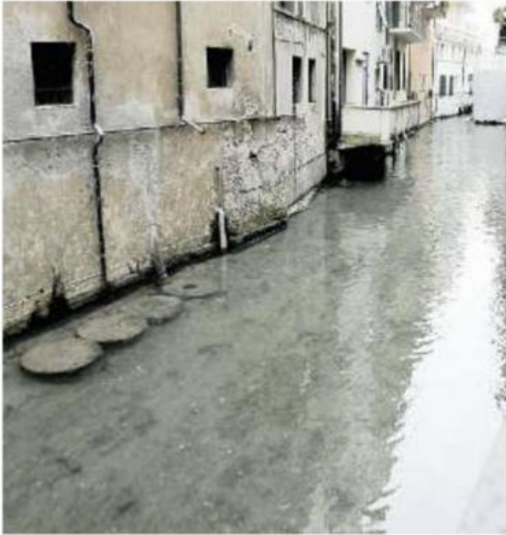
IN CITTÀ La rete di canali rischia di restare quasi a secco
