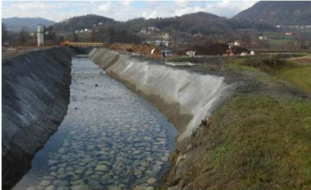
I lavori per modificare il corso del torrente Poscola sono terminati puntualmente. A.C.
