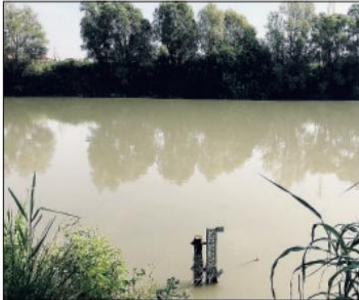
L'Adige a Cavarzere Qui sopra una veduta del fiume, a destra la scala d'accesso con segnate le altezze idrometriche. Ma bisogna scendere tutte le scale e andare in acqua per vedere il livello attuale
