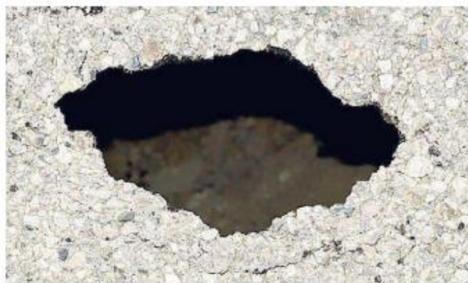
La voragine profonda quattro metri che si è aperta sotto la strada arginale
