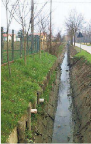
Fondamentale la pulizia dei fossi
