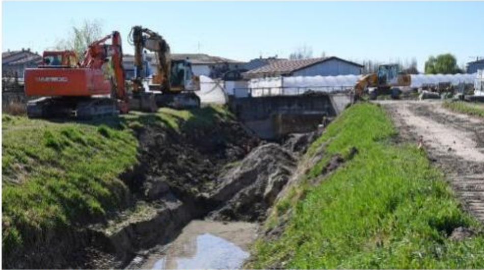
Lavori per la realizzazione del tratto comunale della pista delle Risorgive FOTOPECORA
