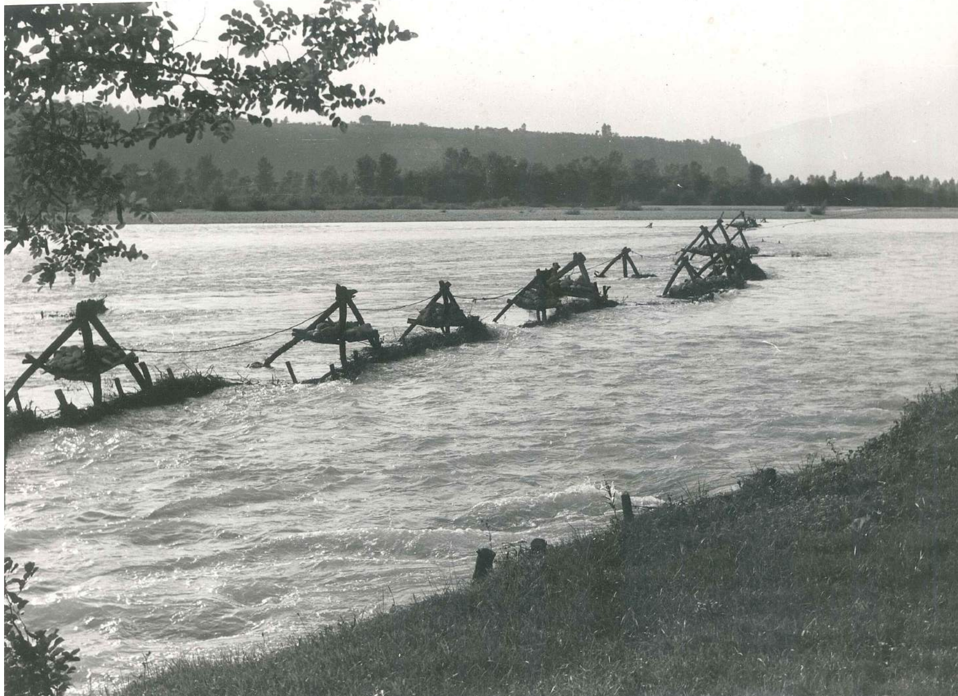
Prime opere di presa sul Piave - inizi '900
