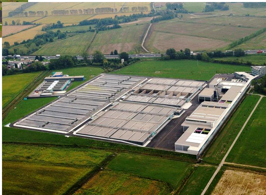
Depuratore Milano San Rocco
