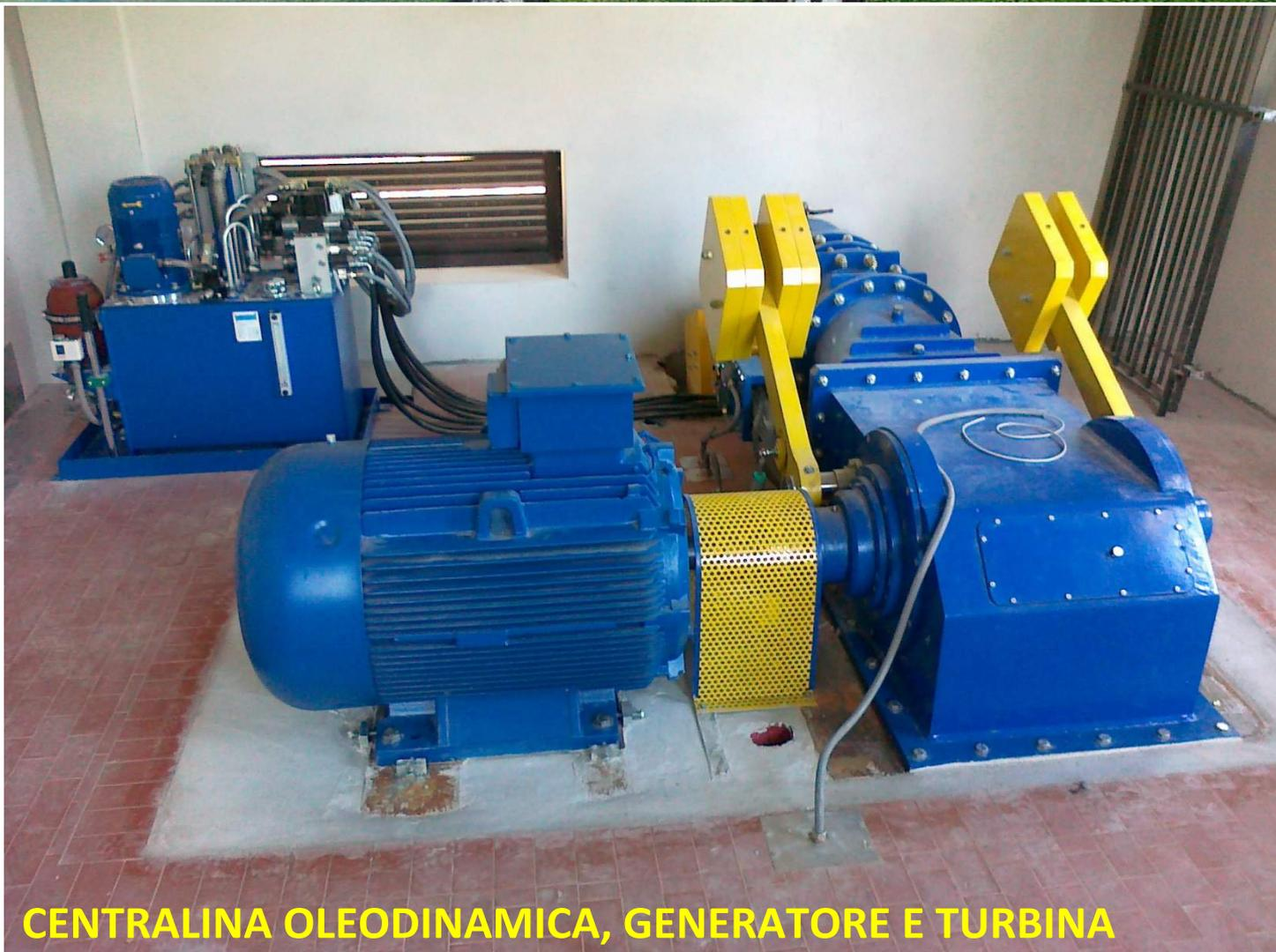
**CENTRALINA OLEODINAMICA, GENERATORE E TURBINA**
